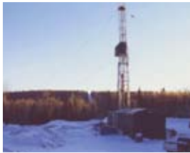
Forage du puits Pétrolia Haldimand n° 1
